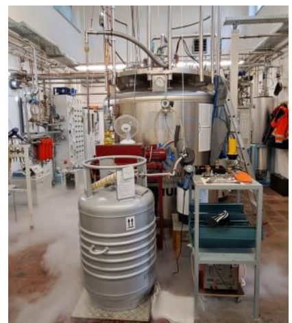
Abb. 4: He-Abfüllstation des L70 von Linde Foto: A. Winnefeld
