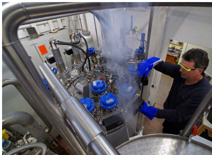
Arbeiten am neuen Heliumverflüssiger
