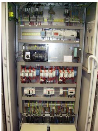
Steuerschrank Heliumrückverdichtung
