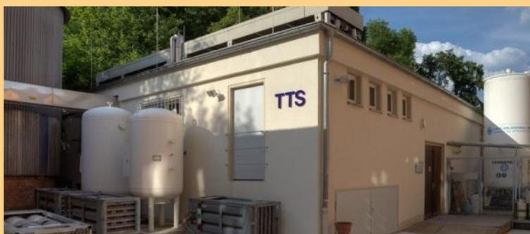
Abb. 3. Heliumverflüssiger der FSU Jena zur Versorgung von Forschungseinrichtungen sowie der medizinischen Diagnostik im Raum Jena. Foto: AG TP
